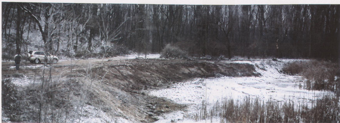
Celkový pohled na tůň z východního cípu po dokončení zemních úprav
