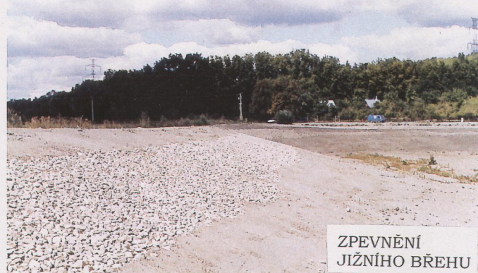
OPEVNĚNÍ NÁVĚTRNÉHO BŘEHU KAMENNÝM ZÁHOZEM S VYTVOŘENÍM PÁSU MĚLČINY (terénní lavice – bermy opevněné dřevěným oplůtkem)
