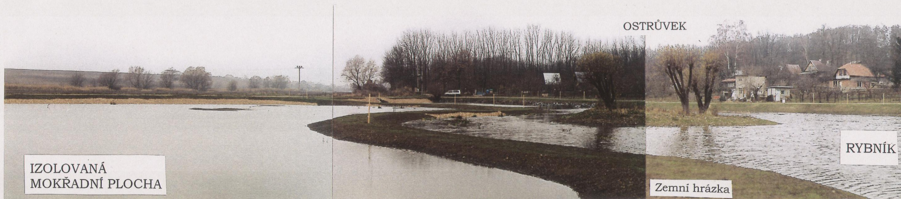
Trasa kamenné hrázky pod hladinou pro zachycování splavenin
