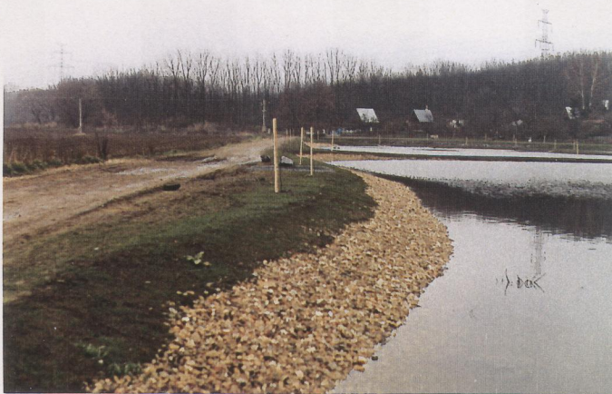
ZPEVNĚNÍ JIŽNÍHO BŘEHU Říčním štěrkekem (Bratčice)
